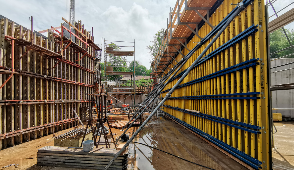
Pohled na staveniště. © ACMS Architects GmbH, Wuppertal
