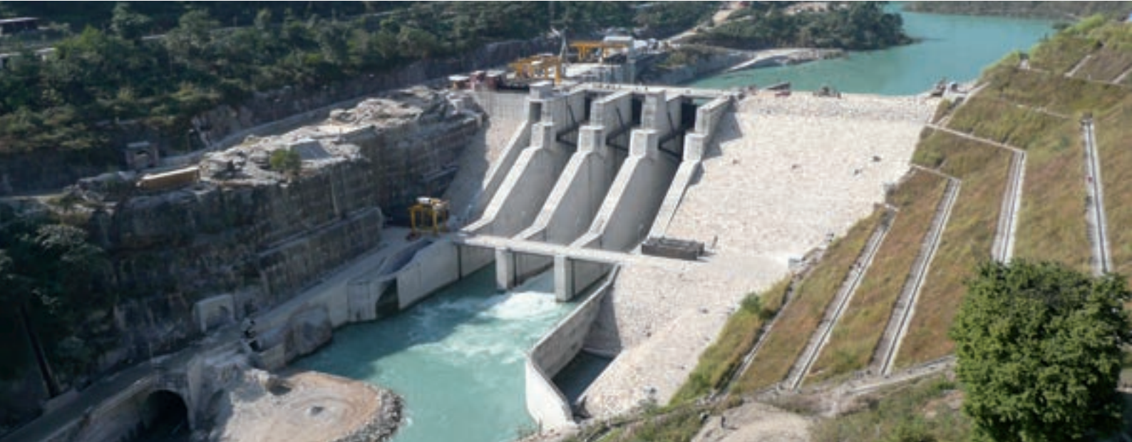
Projekt: Wasserkraftwerk Middle Marsyangdi, Nepal, Bauunternehmer DYWIDAG International GmbH
