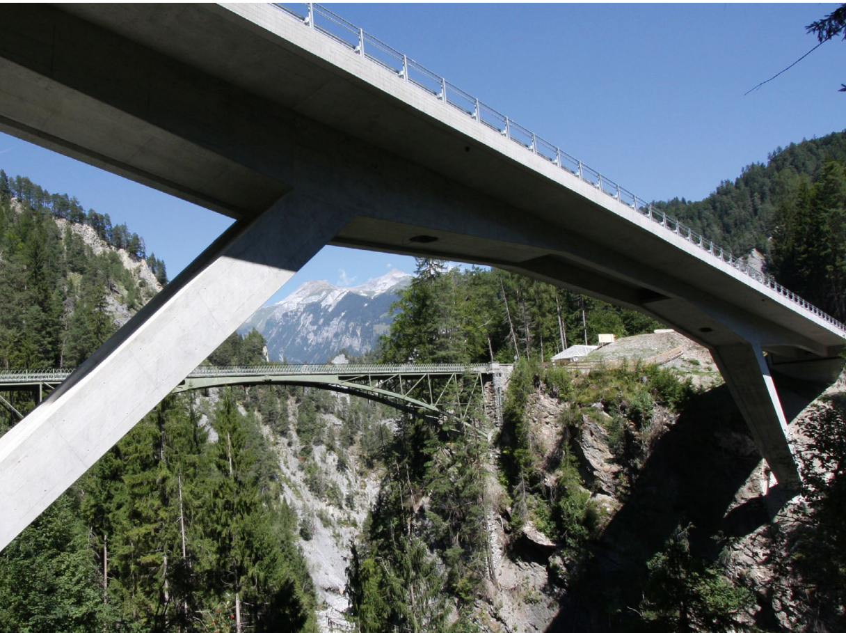
Versamertobelbrücke, Kanton Graubünden, Schweiz
