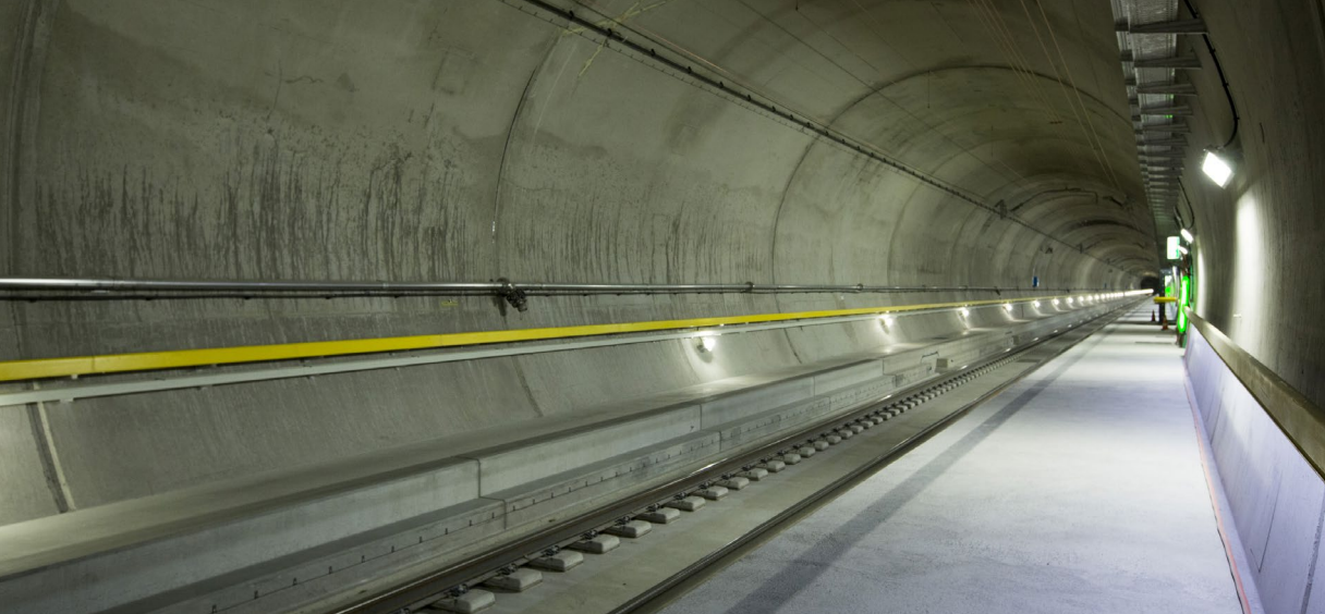
System mit zwei Einspurrohren von je 57 km Länge
