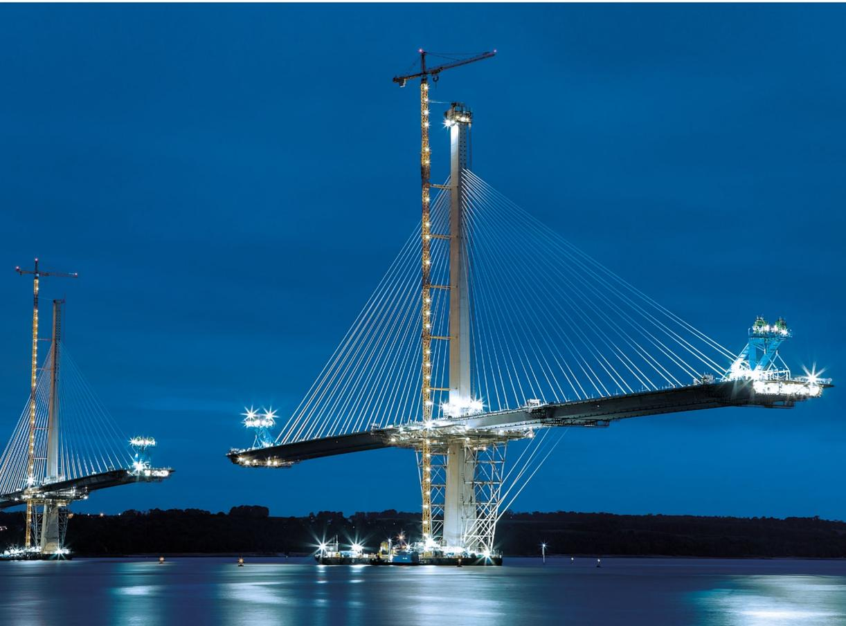
Pylône en béton armé avec hauban précontraint et chaussée suspendue durant la phase de construction.
