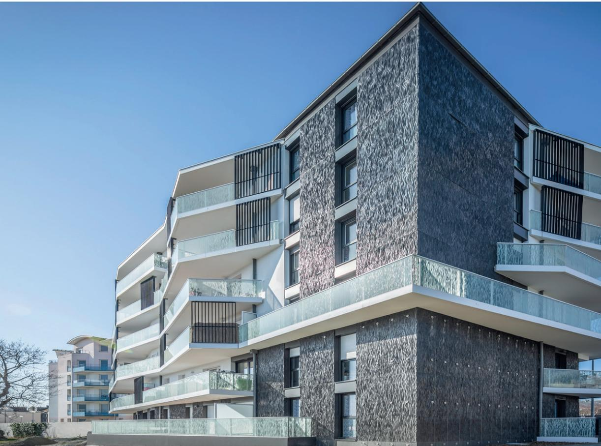
Les murs en béton préfabriqué respirent la vivacité à l'aide de matrices structurales.
