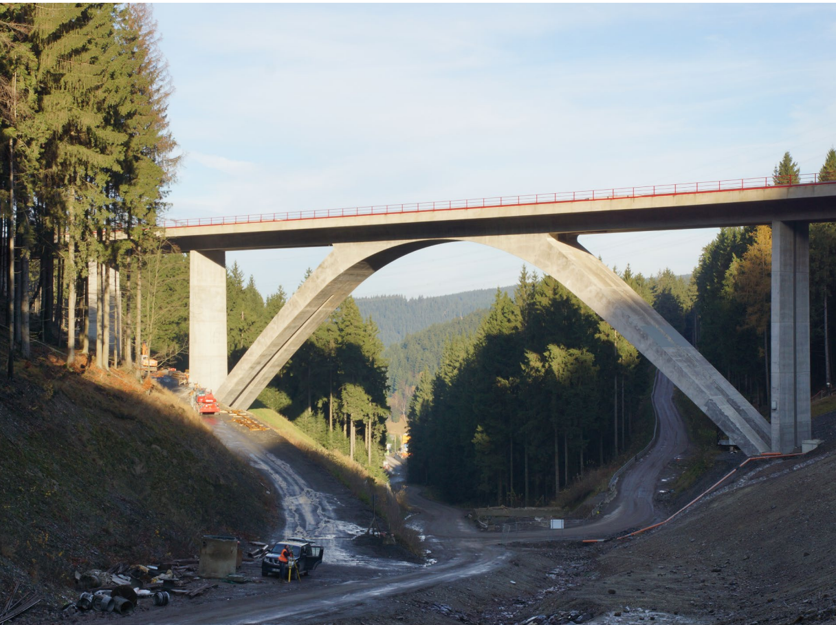
EÜ Grubentalbrücke, Verkehrsprojekt Deutsche Einheit 8.1, Deutschland
