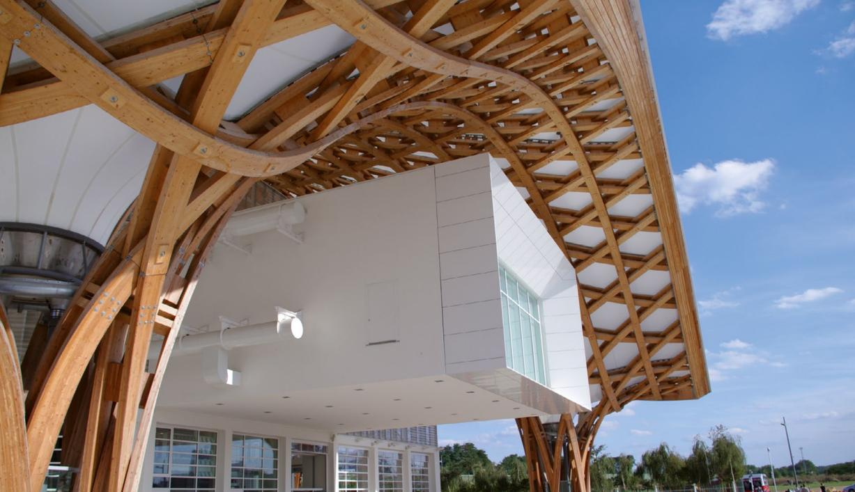
In Zusammenarbeit mit der Firma Demathieu & Bard sowie unterstützt vom Holzspezialisten Professor Dominique Calvi überarbeitete CTE das Originalkonzept. Realisiert wurden die drei Galerien nun als steifere, monolithische Struktur, auf der das Dach sphärisch gleitend aufsetzt. Damit werden die horizontalen und vertikalen Verformungen zwischen dem Tragwerk aus Beton und der umgebenden Struktur aus Stahl und Holz voneinander entkoppelt.
