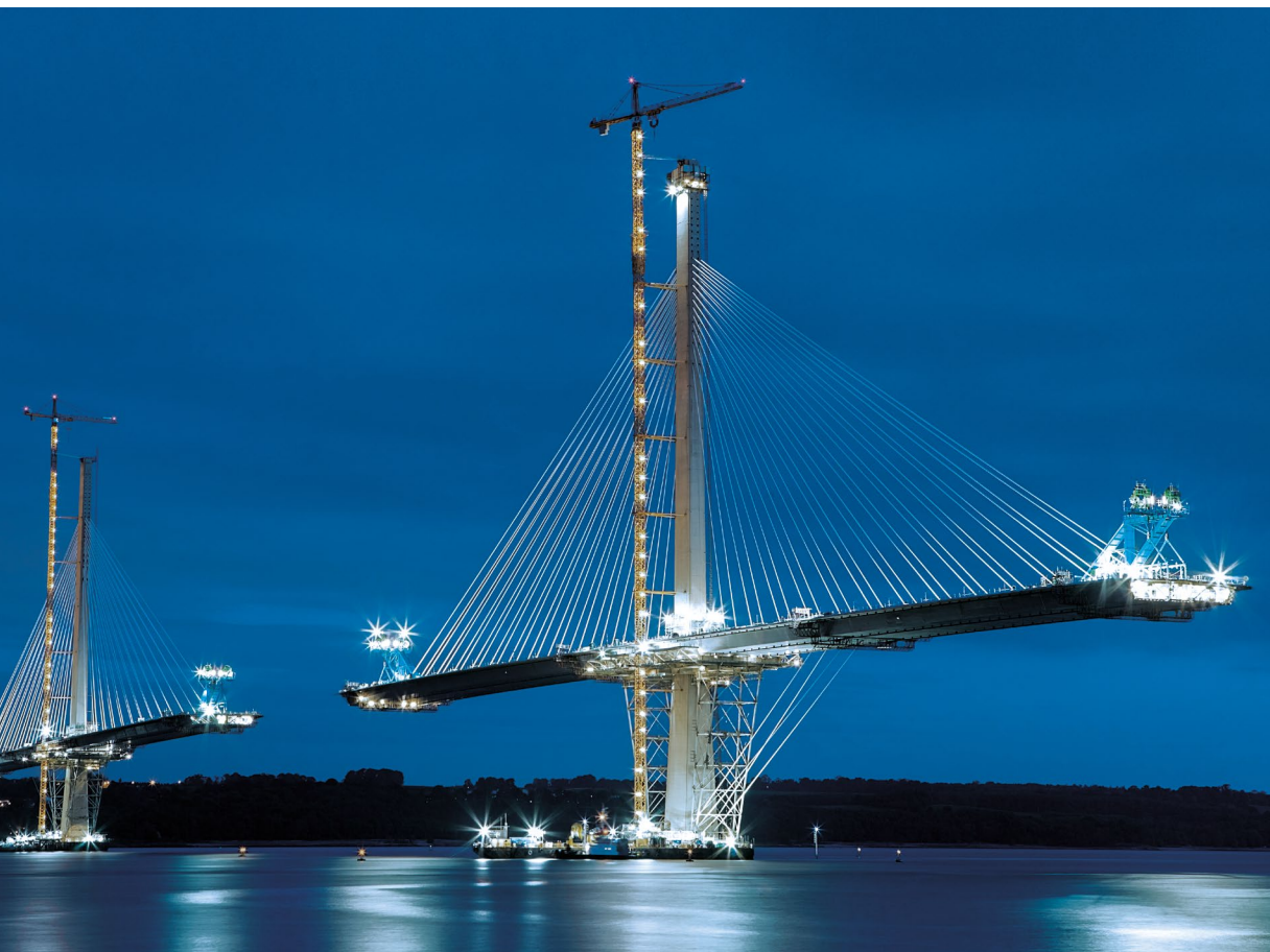
Stahlbetonpylon mit Schrägseilverspannung und abgehangter Fahrbahn während der Bauphase.
