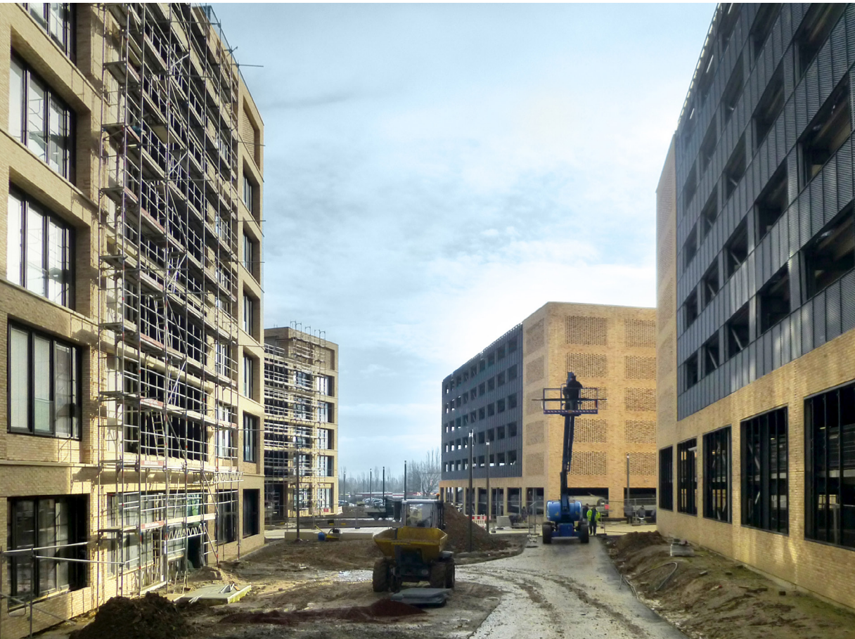
1. Bauabschnitt Blickrichtung Osten zwischen Haus T10 (links) und Parkhaus TP1 (rechts) auf Haus T20 und Parkhaus TP2
