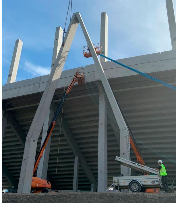
Konstruktive Herausforderung; Die Eigenwillige Ausrichtung der Dachstützen zu den Tribünenbalken erfordert eine knifflige Y-förmige Geometrie.
