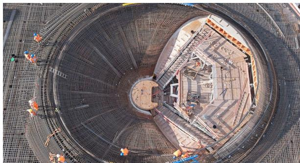
Immagine in alto e a destra: armatura di una colonna a forma di calice della nuova stazione della metropolitana di Stoccarda
