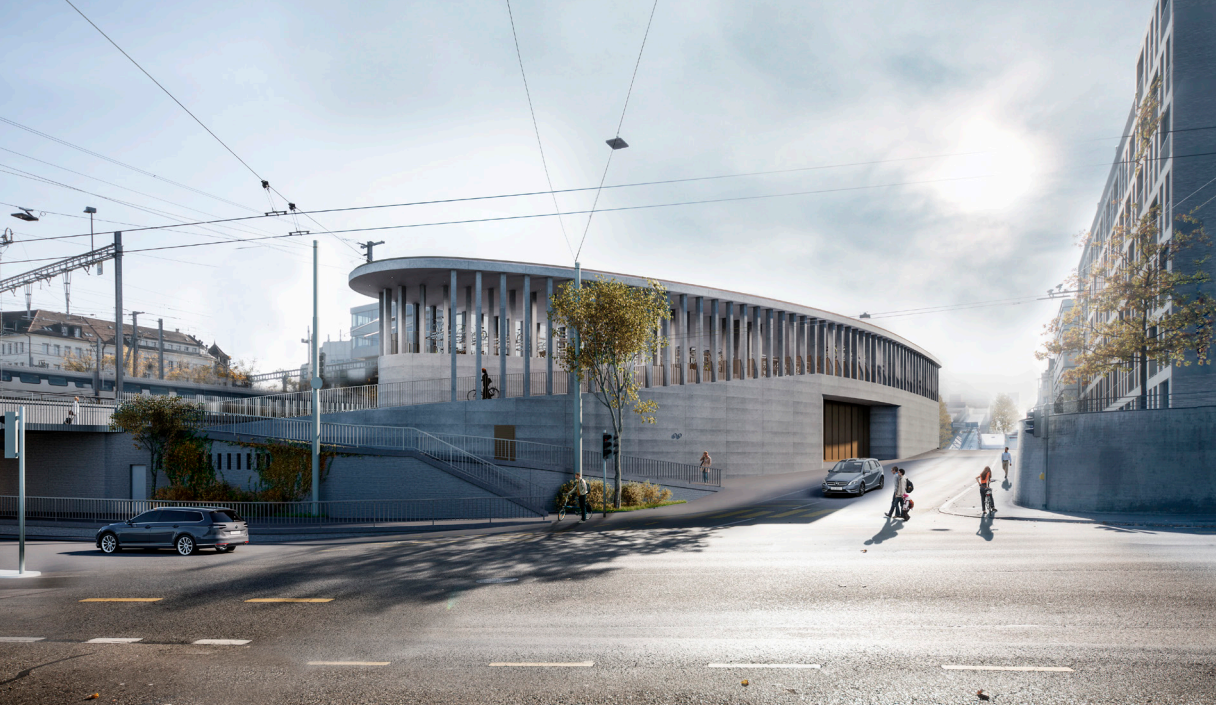
Centro logistico e ciclostazione, vista da Wülflingerstrasse
