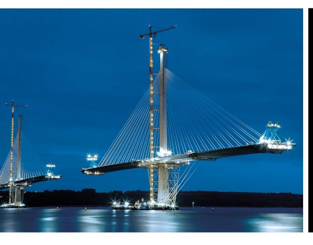
Pilone in cemento armato con ventatura delle funi di sospensione e carreggiata sospesa durante la fase di costruzione.
