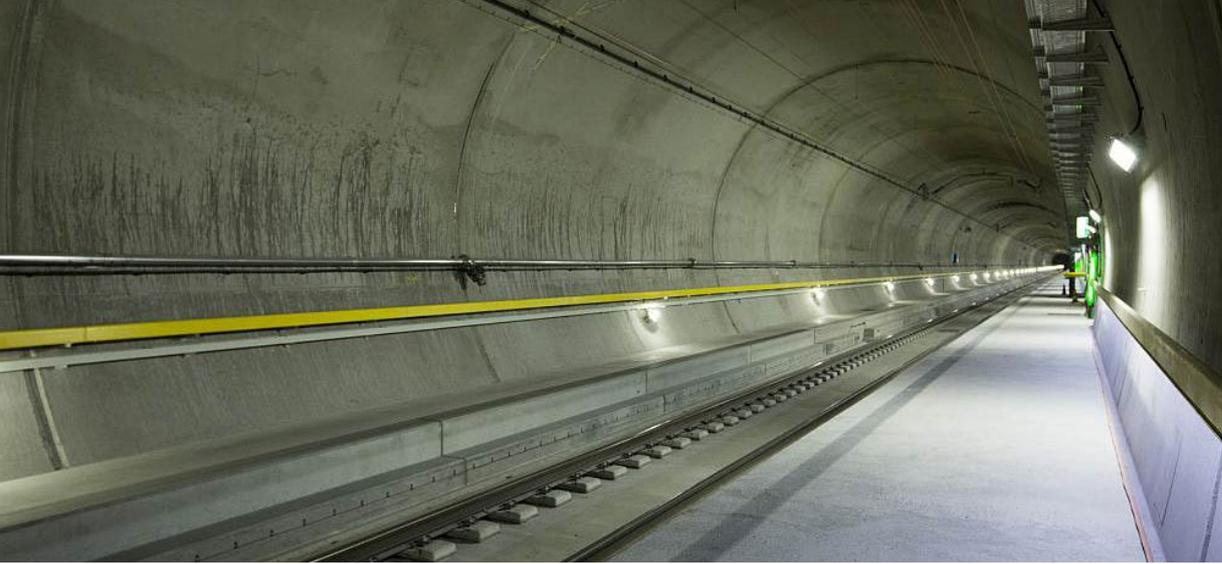
Sistema con dos túneles de vía única de 57 km cada uno
