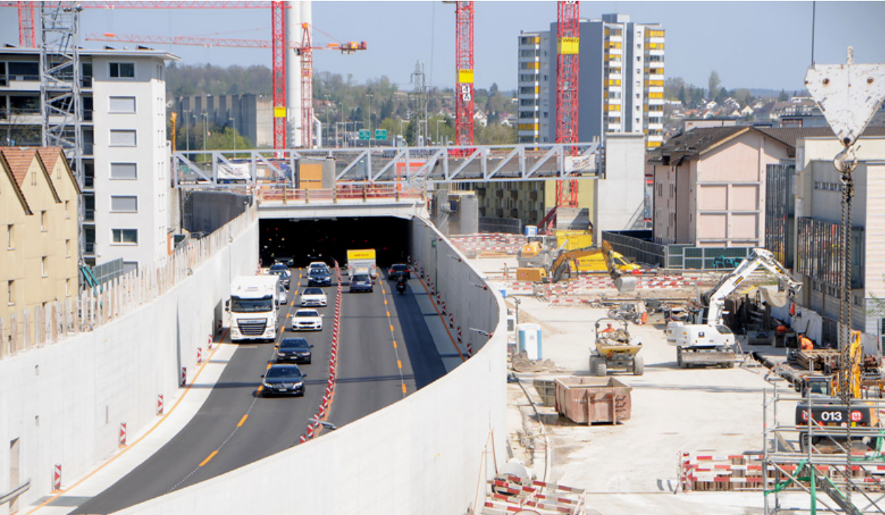
Bereich des Tagbautunnels Einhausung Schwamendingen
