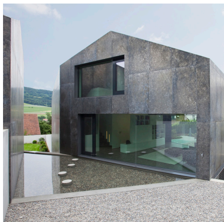
Projekt: Zwei Einfamilienhäuser Oberweningen L3P Architekten ETH FH SIA AG, Regensburg
