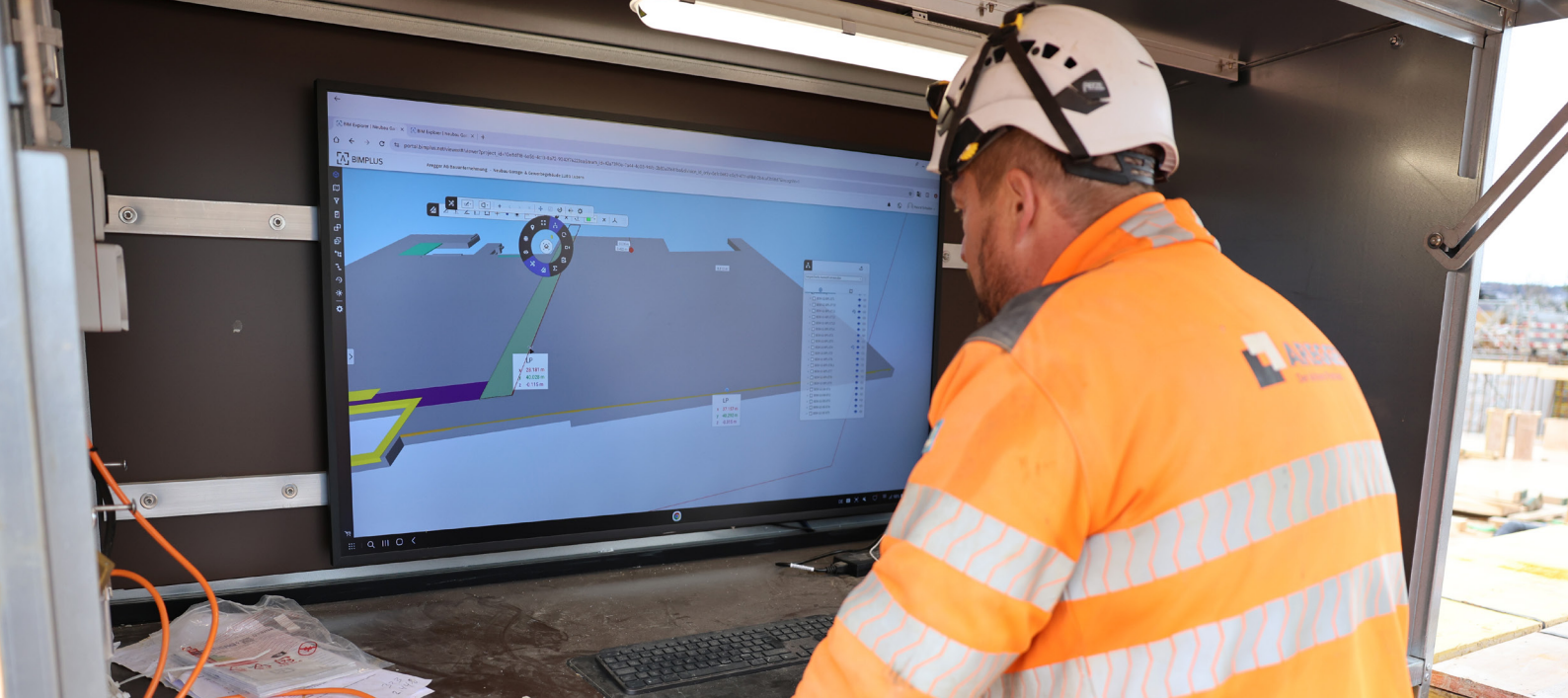
Die Austauschplattform mit allen Funktionalitäten, die es auf der Baustelle braucht (CDE-Plattform BIMPLUS)
