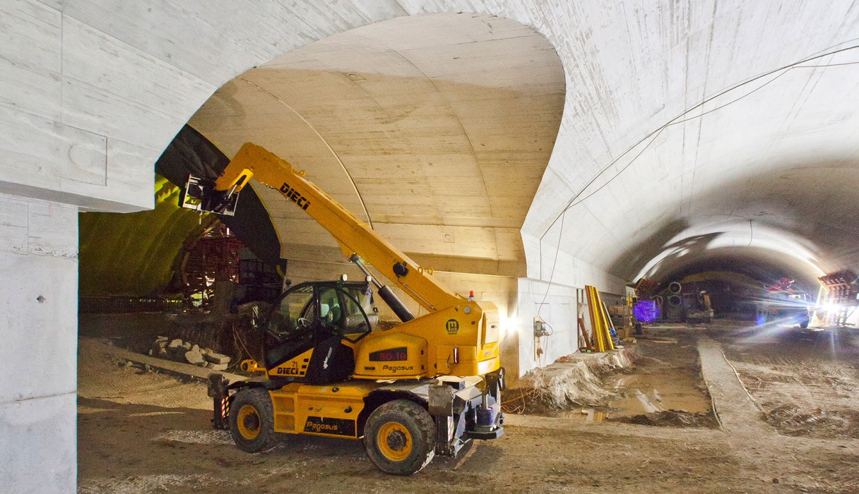
Untertagbau: Deckengewölbe der Hauptkaverne Obere Hauptgasse
