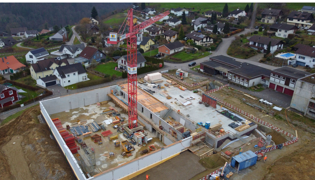
Neubau Turnhalle Rüdigen, Architekten: Buchberg, moos giuliani herrmann architekten ag, Planer: Landolt + Co. AG Kleinandelfingen, © Fotos: Andrea Schären, Landolt + Co. AG
