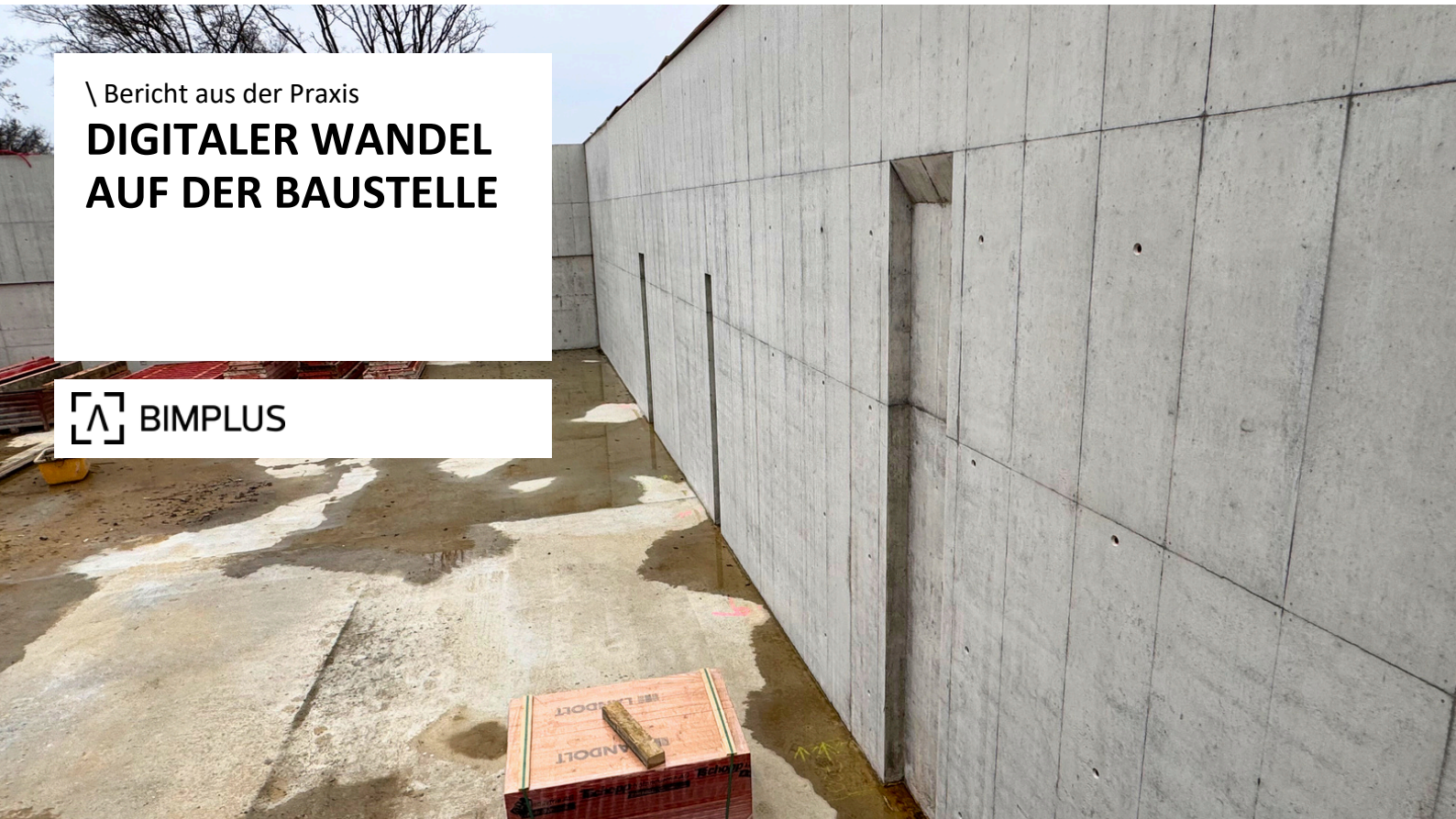
Neubau Turnhalle Rüdlingen, Architekten: Buchberg, moos giuliani herrmann architekten ag, Planer: Landolt + Co. AG Kleinandelfingen, © Fotos: Andrea Schären, Landolt + Co. AG
