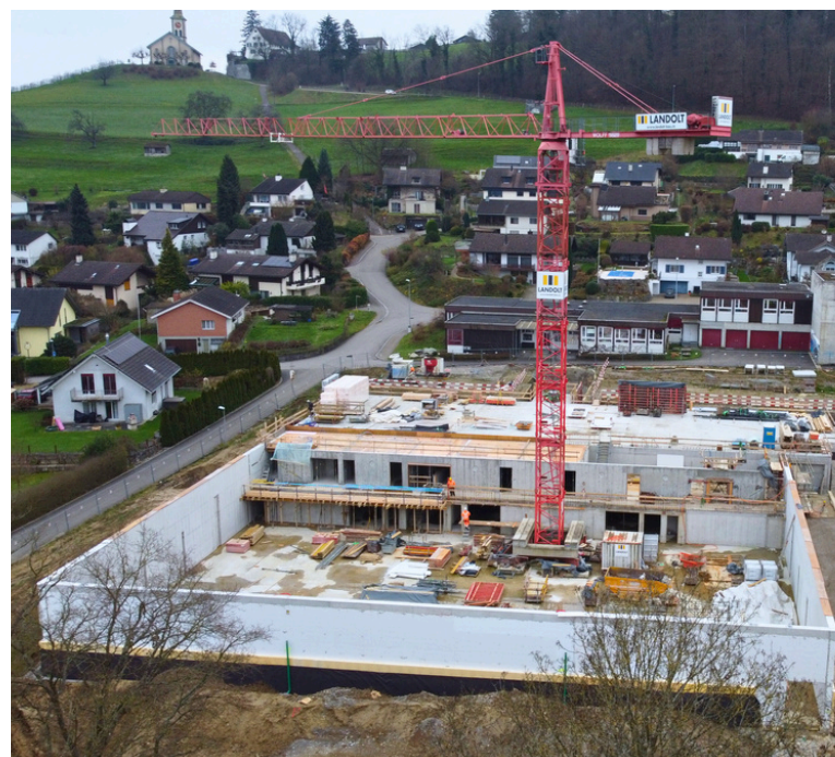
Neubau Turnhalle Rüdlingen, Architekten: Buchberg, moos giuliani herrmann architekten ag, Planer: Landolt + Co. AG Kleinandelfingen, © Fotos: Andrea Schären, Landolt + Co. AG
