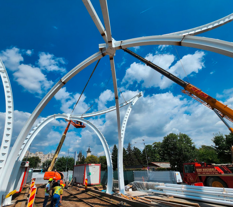
Provisorische Stützen und Schweißarbeiten vor Ort sorgten für Stabilität und Präzision bei der Montage von mehr als 600 einzelnen Überdachungselementen – und das alles innerhalb eines nur dreimonatigen Bauzeitfensters.
