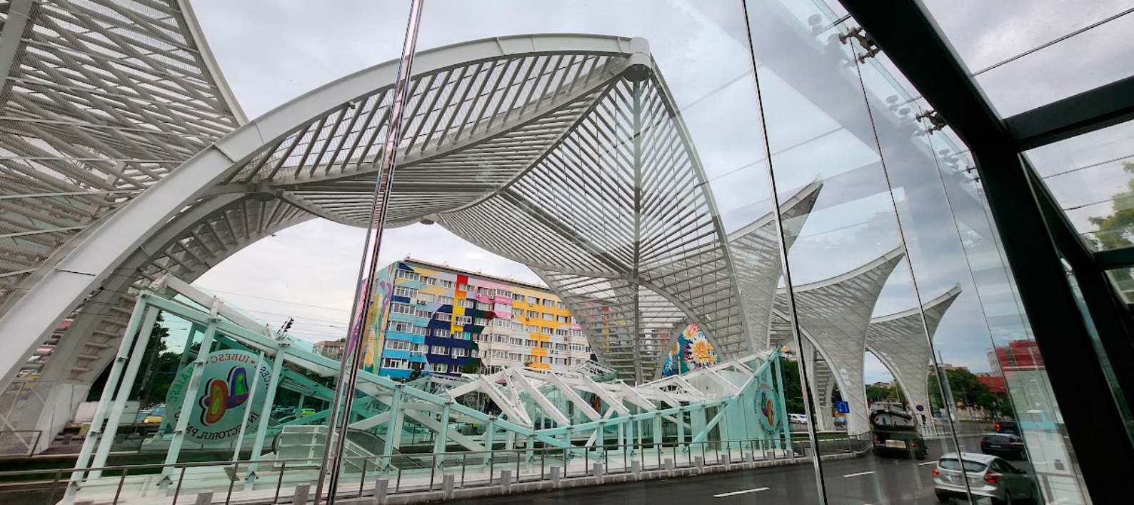
La marquesina de la Puerta de los Héroes terminada. La escultural estructura de acero es ahora un hito visual y un centro de tránsito multimodal para la zona.
