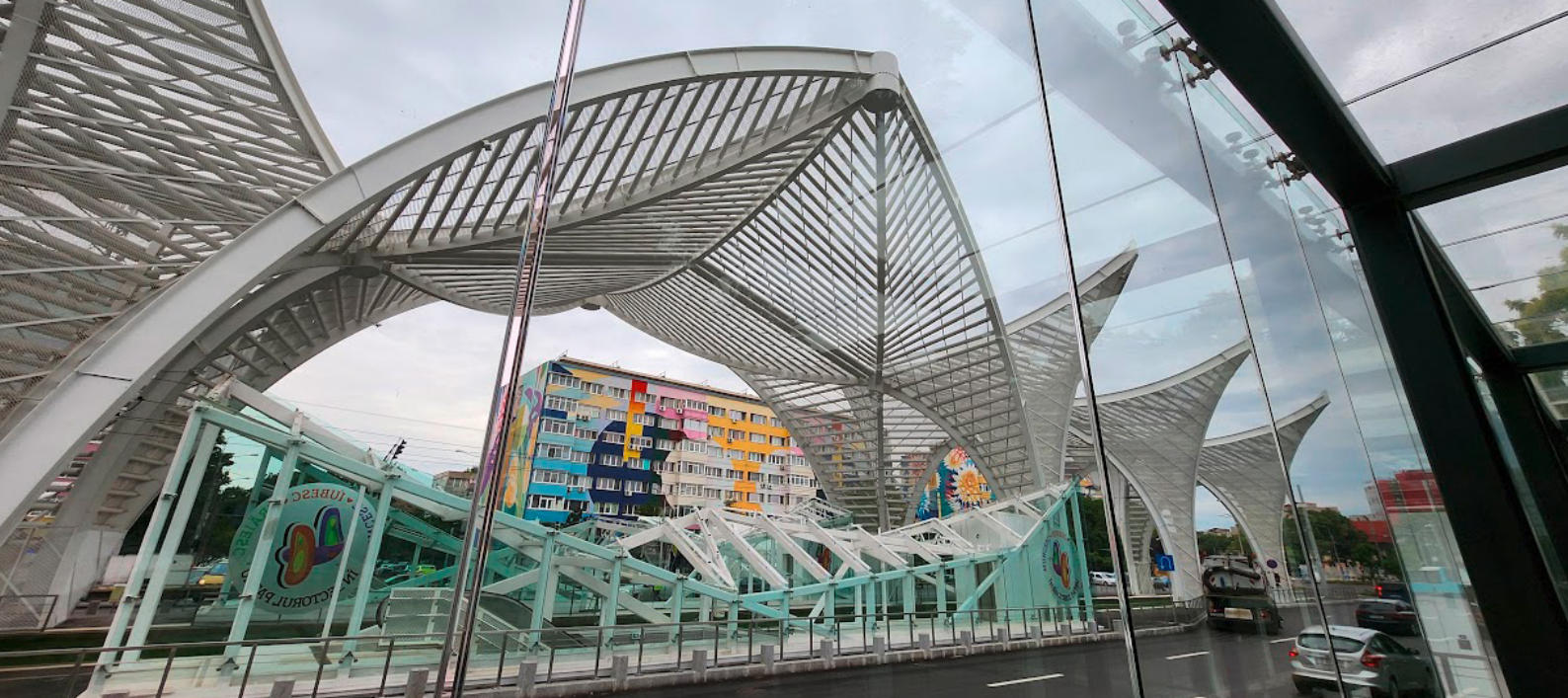
L'auvent de la Porte des héros achevé. La structure sculpturale en acier sert désormais de point de repère visuel et de centre de transit multimodal pour la région.
