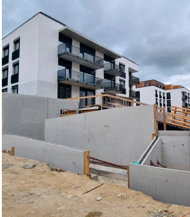
Beim Wohnkomplex Karpatum Residence in Bratislava setzte das Bauunternehmen ganz auf Fertigteile und verwendete vorgefertigte Balkone, Treppen, Elementdecken und Doppelwände.
